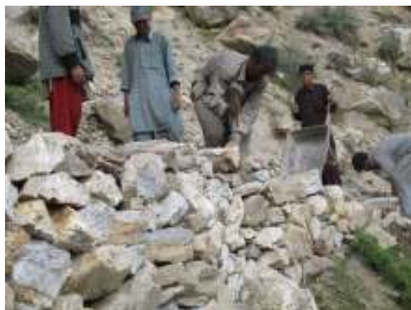
Opěrné zdi musí být z velkých balvanů
