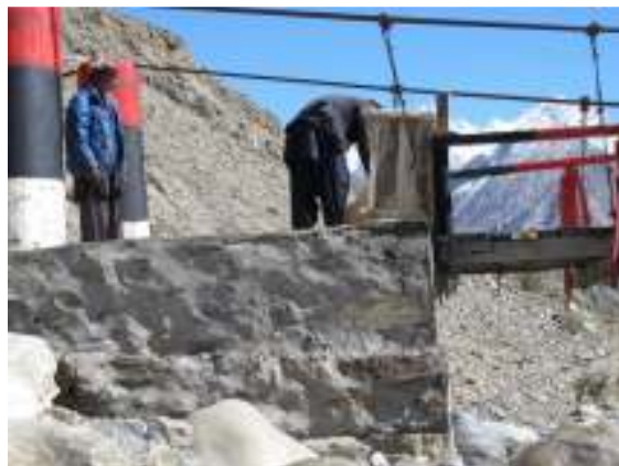
Nová opěrná zeď
