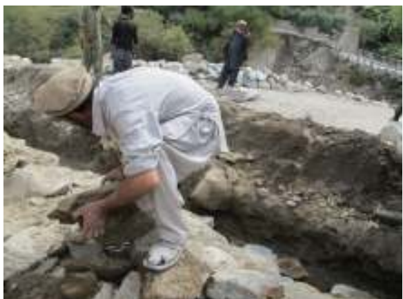
Stavba sběrného kanálu přes cestu
