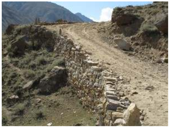
Nové opěrné zdi
