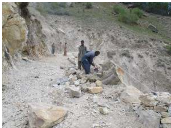
Práce na rozšíření cesty.
