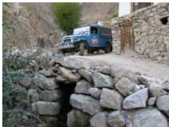
Vyústění kanálu pod cestou
