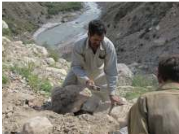
Budování opěrných zdí
