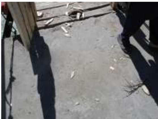
Nový bezpečný nástup na most
