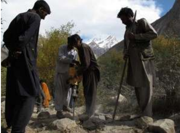
Likvidace balvanů ve vymleté cestě
