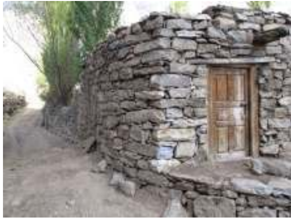
Dům je opět v provozu
