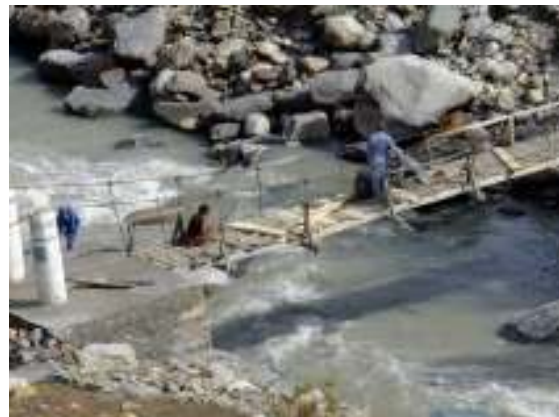
Oprava Kero mostu
