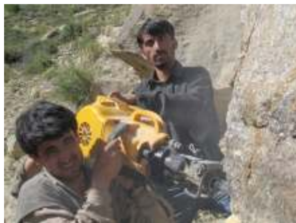
Vrtání otvorů pro výbušninu
