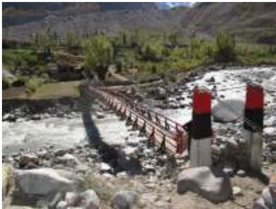
Opravený Basho bridge
