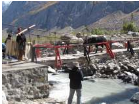
Opravený Khero bridge
