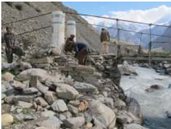
Nové náběhové opěrné zdi
