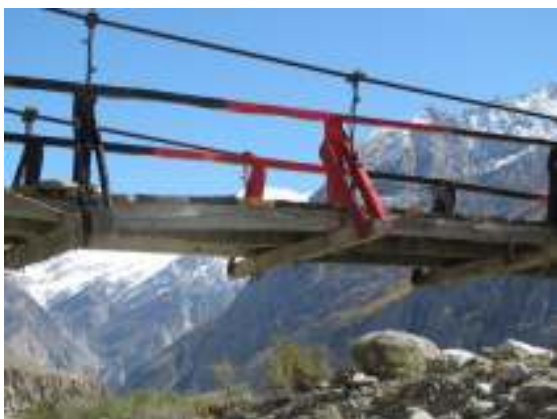
Vyměněné nové nosníky
