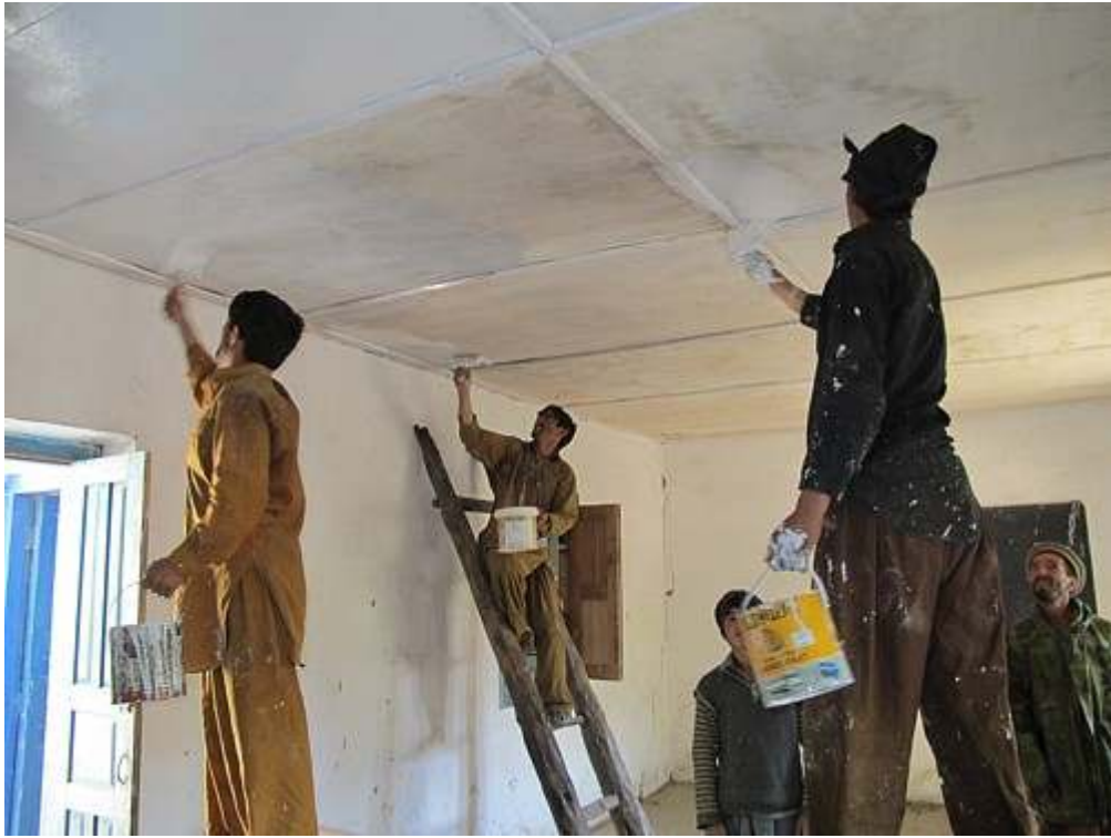
Nový strop a jeho nátěr
