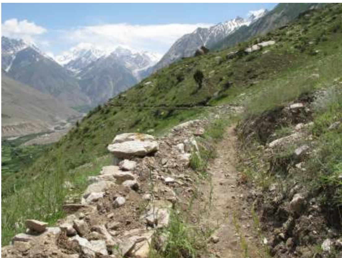
Vyčištěný a zrekonstruovaný kanál nad vesnicí Arandu
