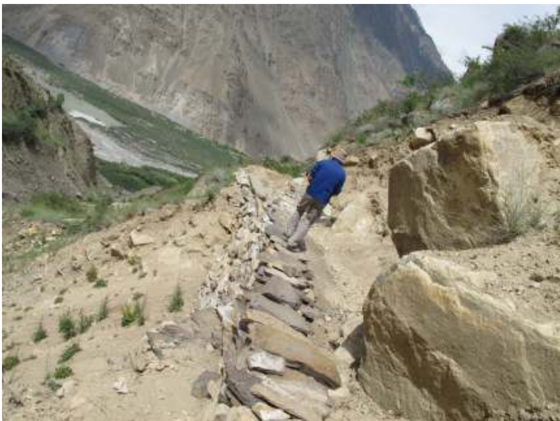
Zatrubněný úsek vodního kanálu přes sesuv svahu
