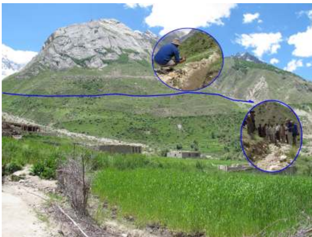
Poloha vodního kanálu. Na svahu je zřetelně znát vysychání svahu.
