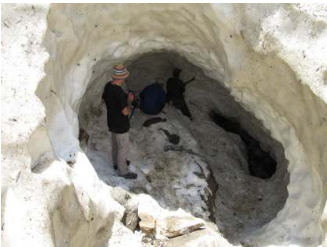
Kopání tunelu k řečišti pro napájení kanálu
