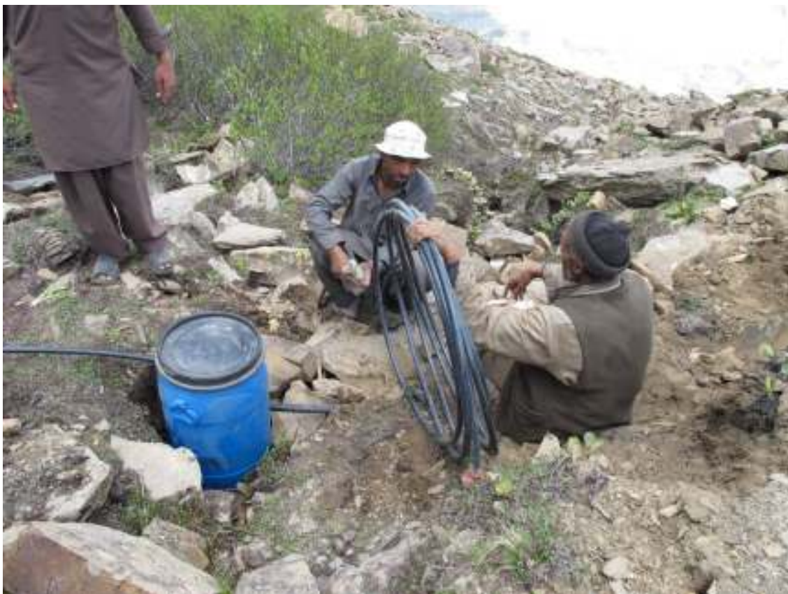
Osvědčený čistící tank, opatření proti ucpávání potrubí - náš vynález
