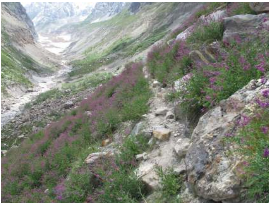
Trasa vodovodu nad vesnicí Remendoc
