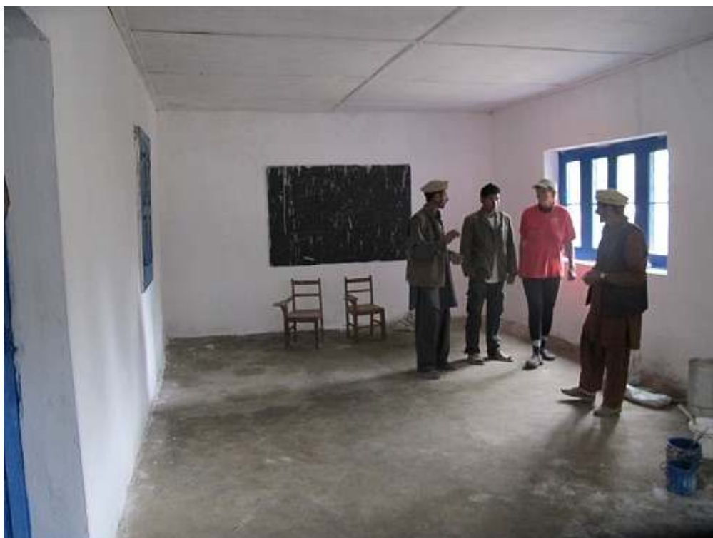
Kontrola probíhajících prací
